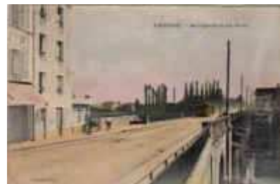
Vue du pont de Chatou en direction de Rueil-Malmaison
